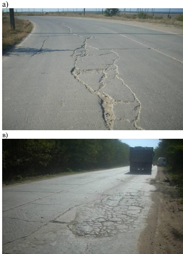
Рис. 3. Етапи розвитку руйнувань жорсткого цементобетонного дорожнього покриття, де а - поздовжні тріщини, що переходять у вибоїни; б - блочні тріщини; в - сітка тріщин, проломи ц/б плити; г - викришування, вибоїни, руйнування більше 75% площі плит
