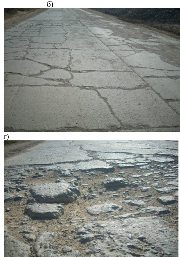
Рис. 3. Етапи розвитку руйнувань жорсткого цементобетонного дорожнього покриття, де а - поздовжні тріщини, що переходять у вибоїни; б - блочні тріщини; в - сітка тріщин, проломи ц/б плити; г - викришування, вибоїни, руйнування більше 75% площі плит
