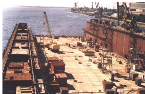
Рисунок 11 - Монтаж башен дока на плаву
