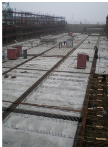
Рисунок 5 - Формирование днища железобетонного понтона на стапеле большой док-камеры
