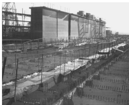
Рисунок 9 - Установка в большой док-камере блоков башни на железобетонный понтон композитного дока подъемной силой 8500 т
