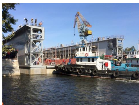
Рисунок 13 – Транспортирование композитного автономного плавучего дока "ERENEOS" грузоподъемностью 7100 тонн [7]
